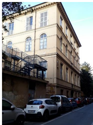
Figura 1.1 - Vista della facciata Sud-Est
