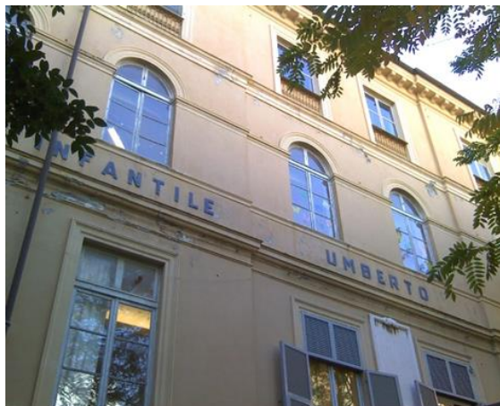
Figura 4.2 – Rilievo termografico della parete Nord al secondo piano
