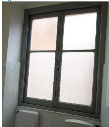
Figura 4.3 - Particolare dei serramenti in alluminio
