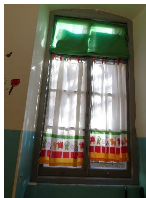
Figura 8.1 – Particolare dei serramenti esistenti
