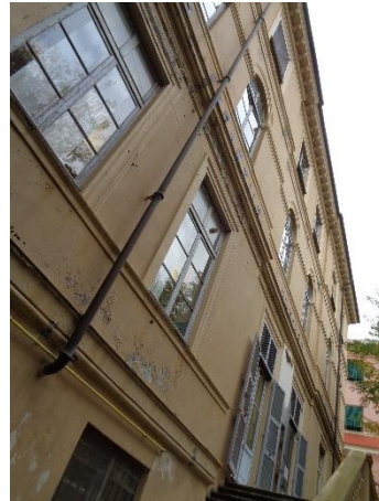
Figura 4.1 - Particolare facciata ovest fabbricato
